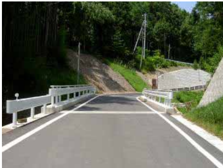
道路工事の際、新設された橋梁部に、添架配管を行いました
