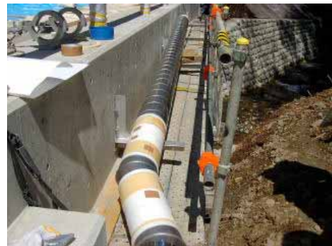
ソケット部表面には、保温テープ( t=4 )を2重巻きにした後、カバー鋼板を取り付けます。
