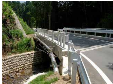
完成状況。橋梁部の形状に合わせ、曲管等を使用しました。
