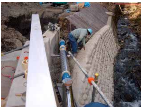
空気弁の取り付け部には、フランジ付被覆チーズを使用しました。
