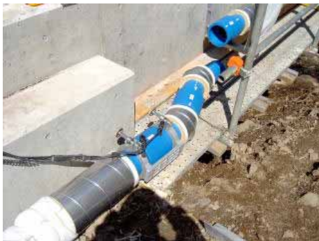
コンクリート架台を避ける為、 22^{\circ}1/2 曲管を使用しました。
