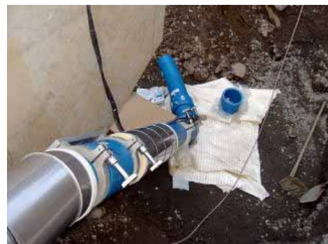
橋梁端部では、 45^{\circ} 曲管を使用して高さ調整後、埋設部で既設管と接合しました。
