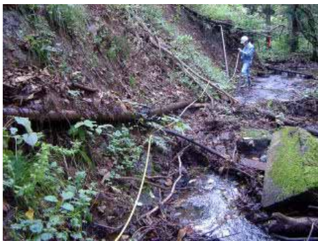
〔事例３〕破損管路の復旧 土砂崩れにより、破損した導水管 75 A の復旧作業にエスロハイパー JW 75 A を使用しました。
