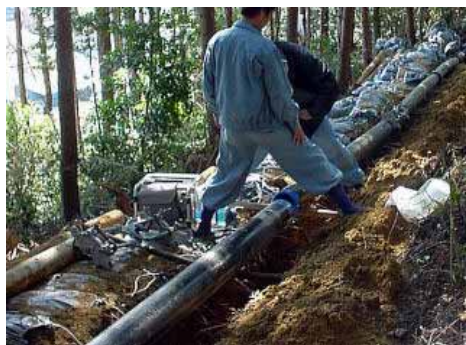
〔事例1〕山間傾斜地での施工 エコハイパー JW150Aの施工状況。 φ150 - 5mの管重量は、約50kg/本。 重機が侵入できない山間部でも、人力で小運搬出来ます。
