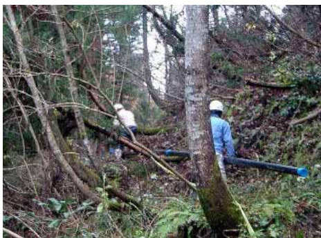
〔事例３〕破損管路の復旧 直線部分は、作業性の良い場所で、あらかじめ E F 接合して作成した長尺管を運び込んで施工しました。75 A の場合 2 本つないでも約 30 kg と軽量です。
