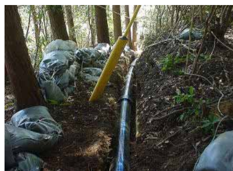
〔事例1〕山間傾斜地での施工 外面保護層には、柔軟性の高い低密度ポリエチレンを採用。エスロハイパー同様生曲げ施工により、構造物を避けて、配管出来ます。
