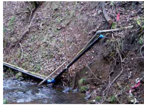
〔事例３〕破損管路の復旧 土砂崩れが発生した部分は、地盤が安定していない為、斜面下に配管を布設していきます。
