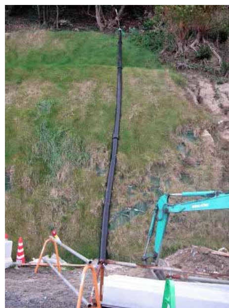
〔事例2〕急傾斜地での施工 急傾斜部分など、掘削が困難な場合でもエコハイパーなら、紫外線劣化の心配がありません。安心して使用できます。
