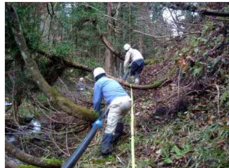
〔事例３〕破損管路の復旧 柔軟性のあるエコハイパーなら、足場が悪い山間部でも、樹木を避けながら布設場所まで運び込めます。
