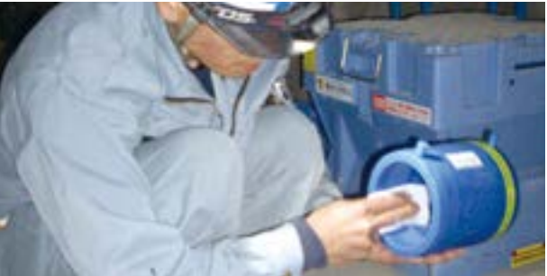
⑥融着面の清掃（継手側）
