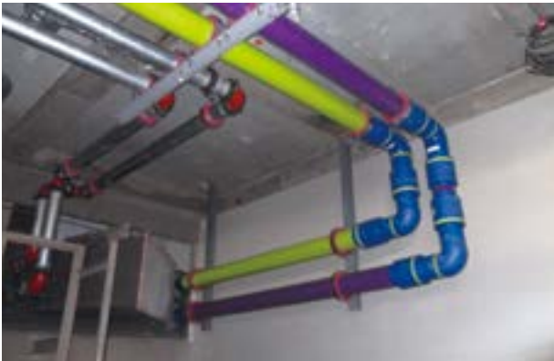
天井内配管（2色の管の使用による誤接続防止）
