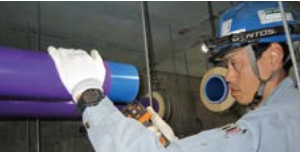
④融着面の切削（ハンドスクレーパー）
