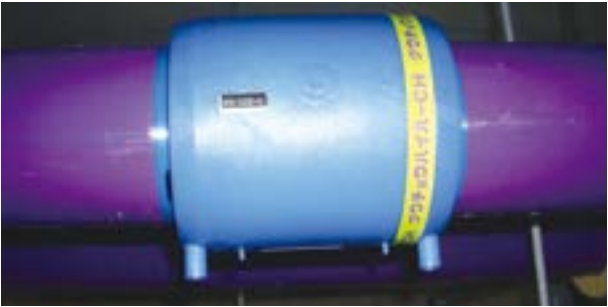
⑨クランプ保持後、取り外して融着完了
