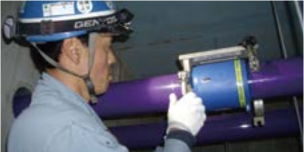
⑦クランプの取り付け
